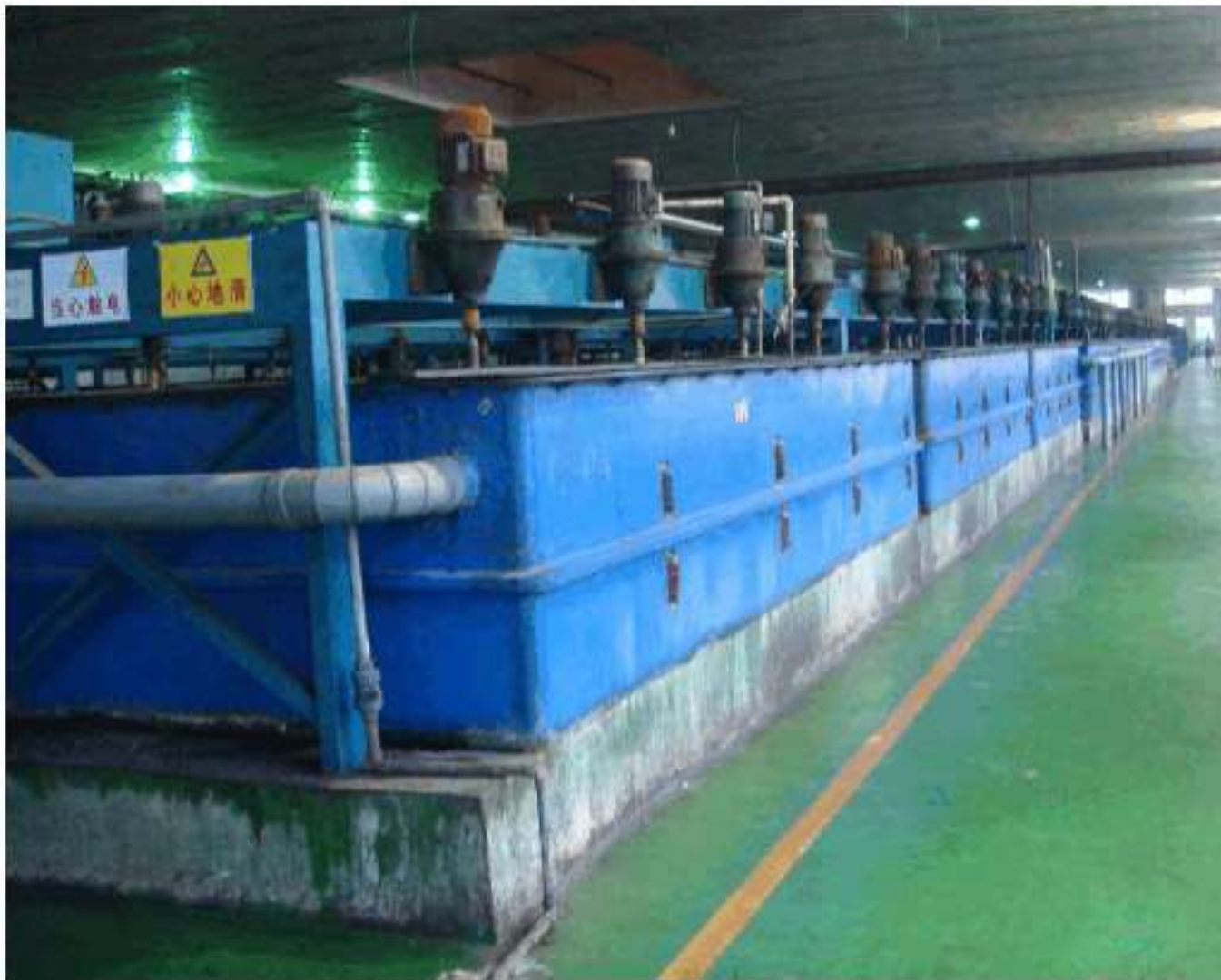
写真 1 溶媒抽出工程（ミキサーセトラーのライン）
