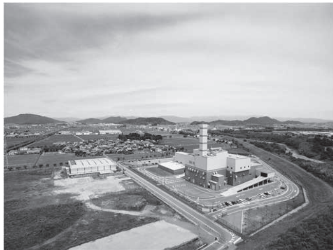
図表 6-4 : 公設民営 (Design Build Operate) 形式で受託した 「近江八幡市エネルギーセンター」
