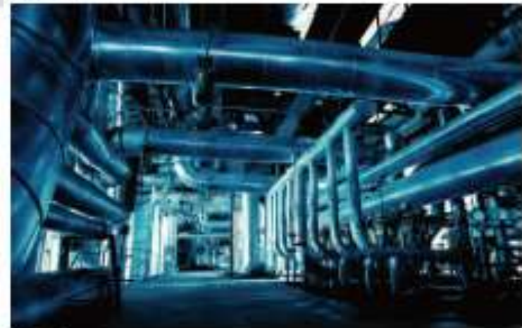
発電プラント Power Plant
